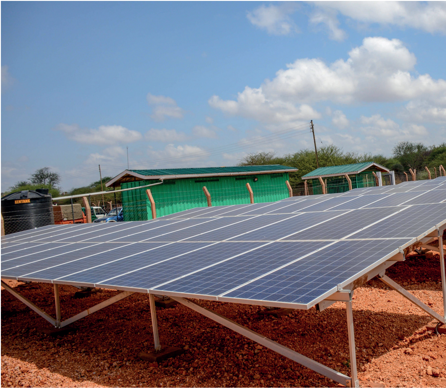
Off-grid Solar mini grid
